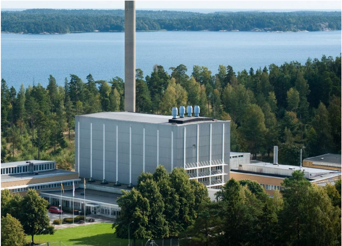
Figur 33. Tidigare R2-reaktorn som nu har rivits. Ny hanteringsanläggning uppförs med lägre utförande.
