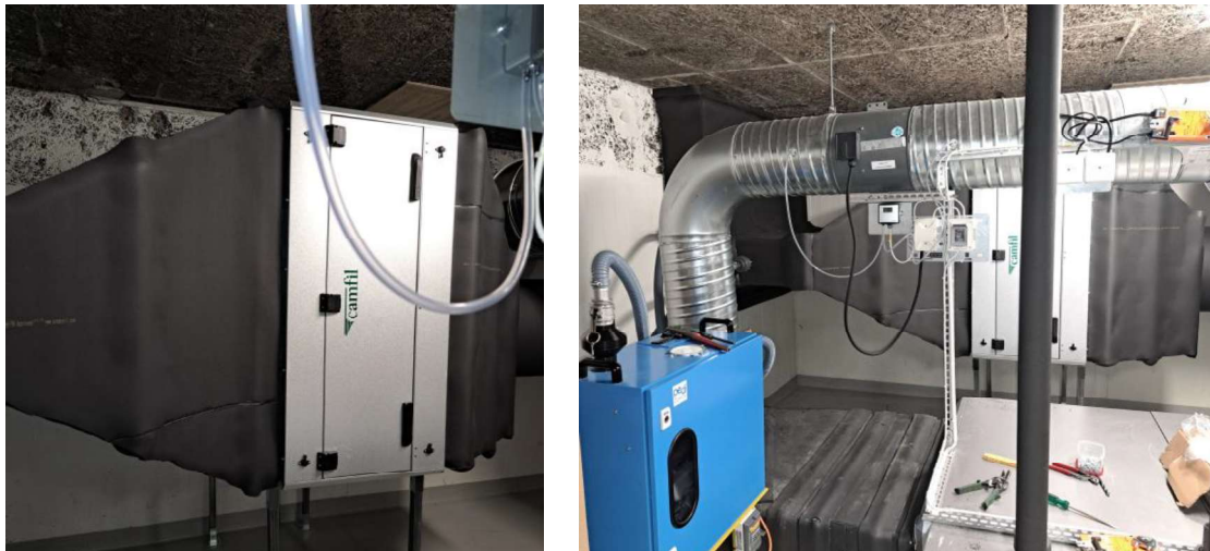
Figur 36. HEPA-filter samt utrustning för utsläppsmonitoring.
