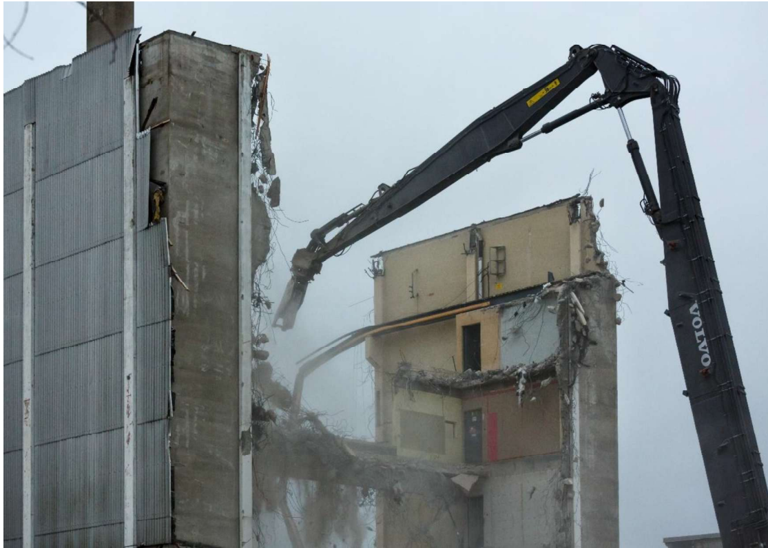
Figur 22. Rivning av R2 reaktorbyggnad, 2024.
