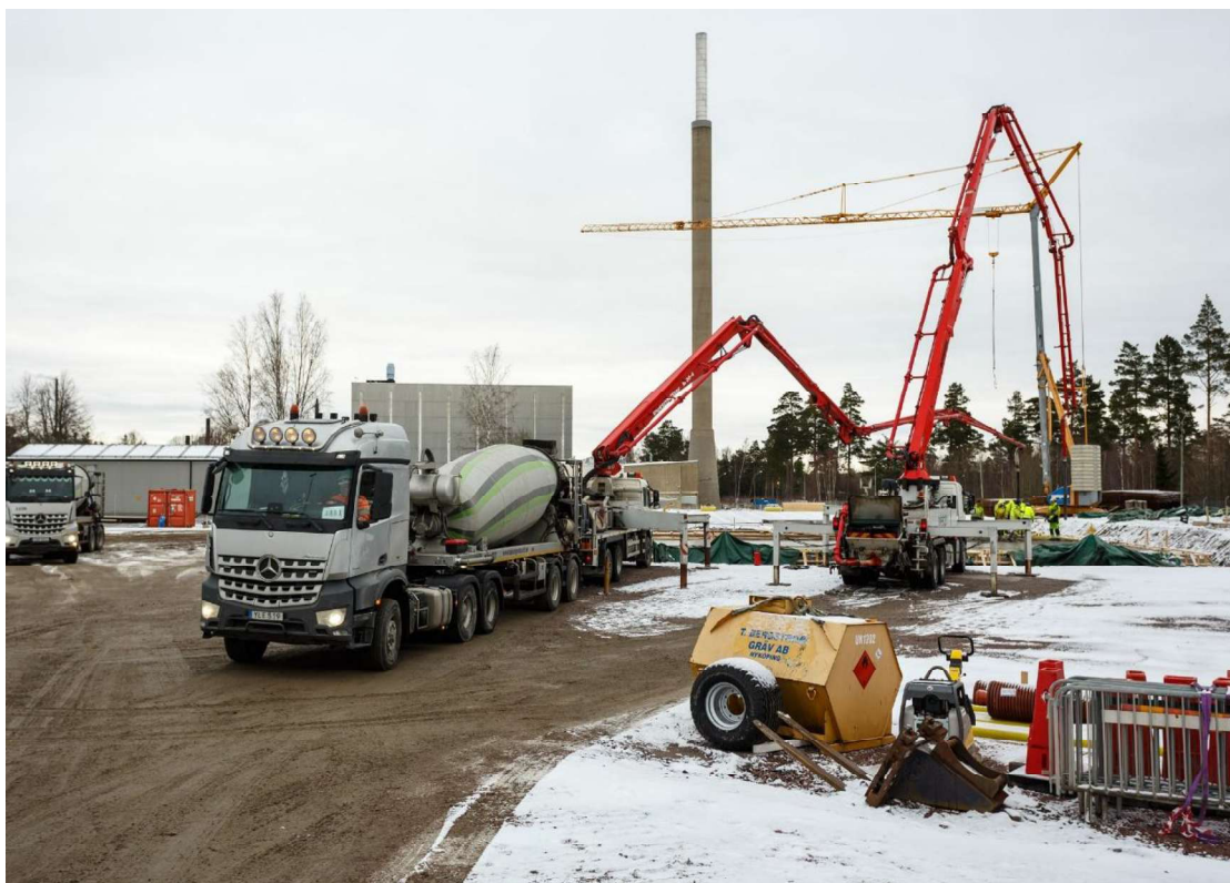
Figur 28. Byggnation av mellanlager, 2020.
