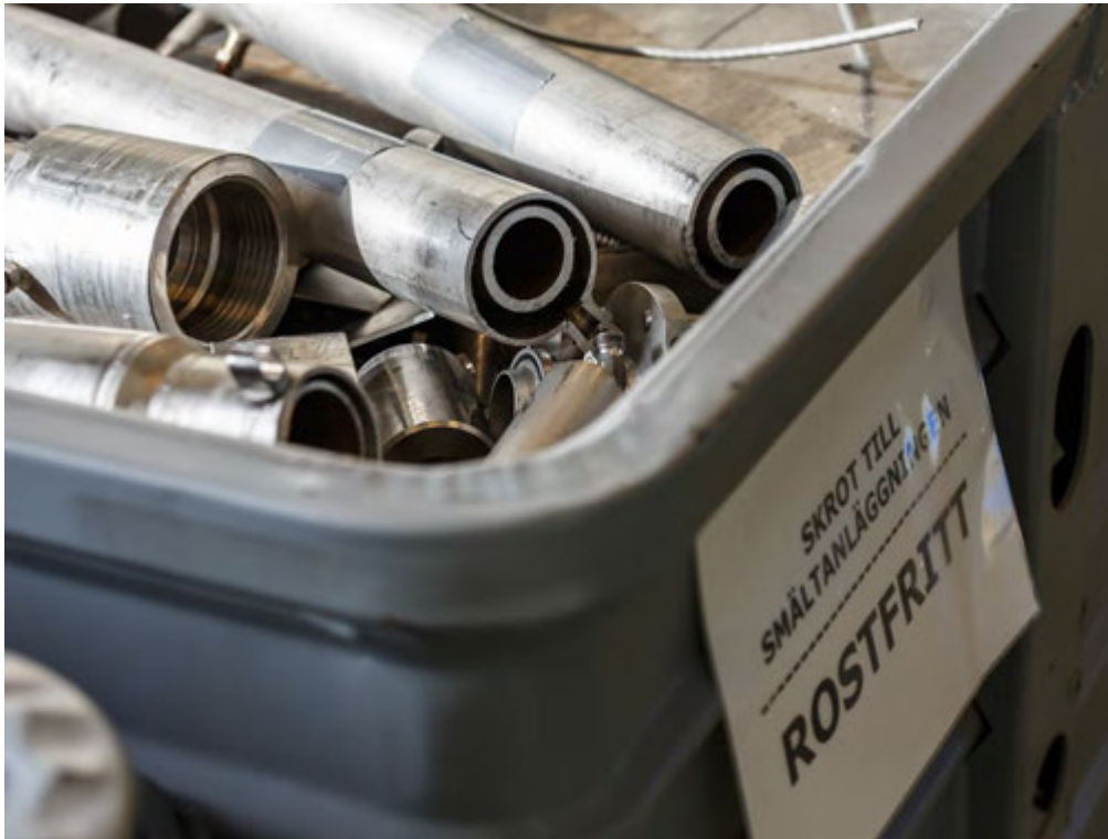
Figur 8 Utsorterad metall vid rivning, Källa: AB Svafo.
